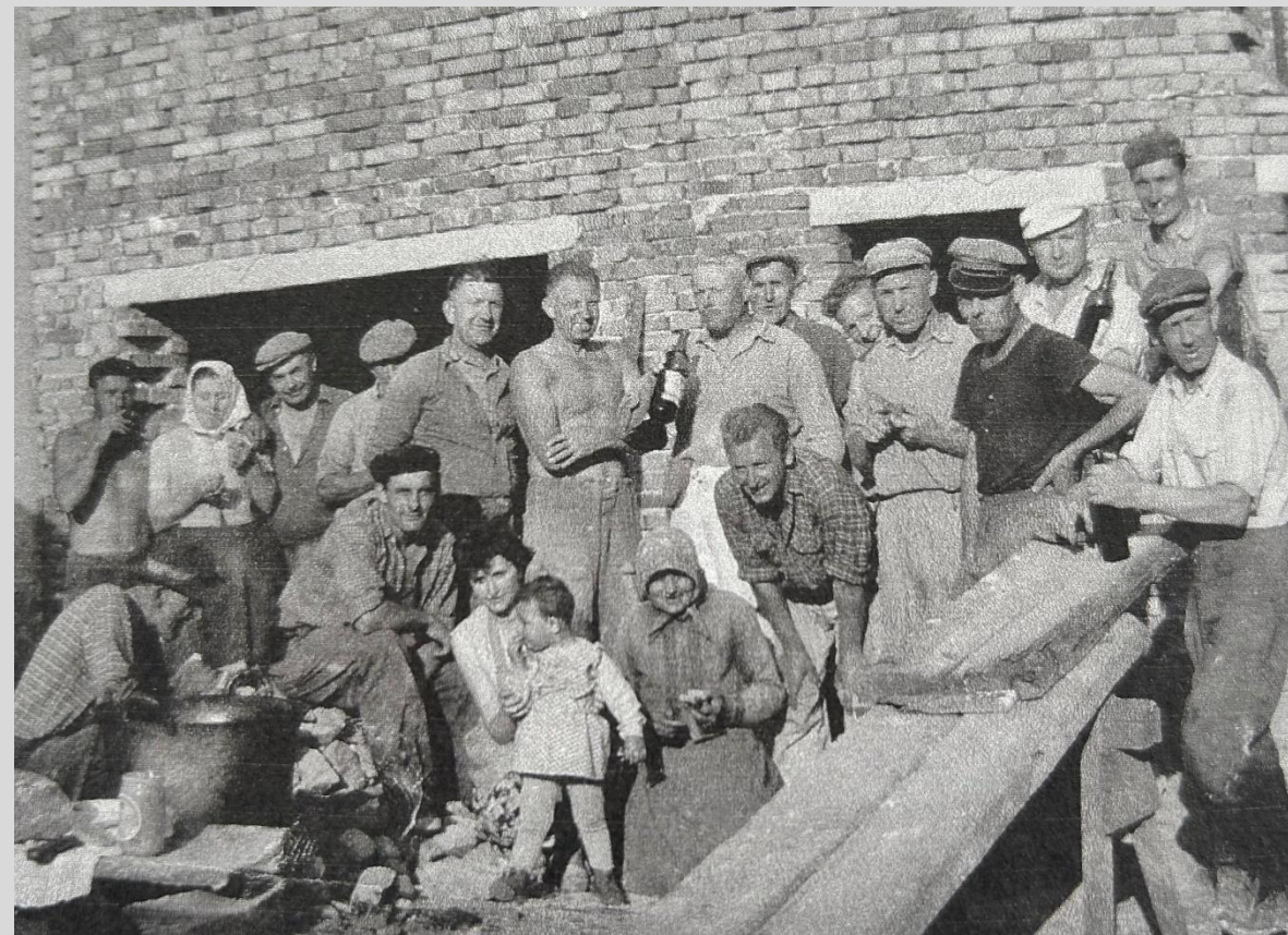
Otcovi spoluvězni z Jáchymova při stavbě domu paní Petrlové
